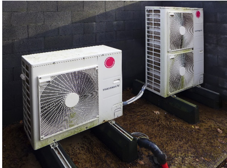
Links Hybride systeem met warmtepomp (A) en flink buffervat (B) en stand-by gasgestookte HR-ketel (C) voor piekdagen. Rechts een serie buiten-units of verdampers van een lucht-water WP. Zij kunnen soms om visuele redenen – lelijk gezicht – en vanwege het beperkte geluid van de ventilatoren een belemmering voor toepassing van dit type WP in de gegeven monumentensituatie vormen. © ejn
